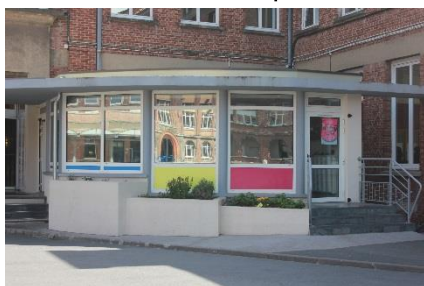
Bureau de la vie scolaire - Cour 1
