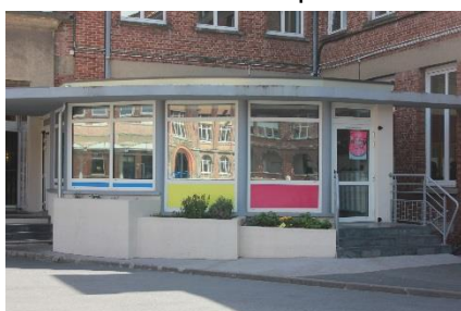
Bureau de la vie scolaire – Cour 1
